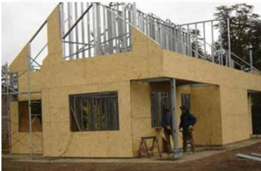
Para el cálculo de la resistencia total del muro, no solo se tomará en cuenta la capacidad de carga del tablero estructural sino también la medida del mismo, tipo de perfiles y modulación, tornillos, medidas y distancias de separación y tipos de anclajes de fijación del panel y su ubicación, según lo establecido en los capítulos 2305 y 2306 del International Building Code.
